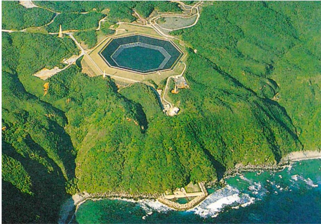
圖 2I.1 日本沖繩抽蓄式海水水力發電廠（鳥瞰圖）<sup>932</sup>
